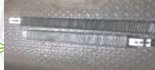
Heater Bank-142kw
